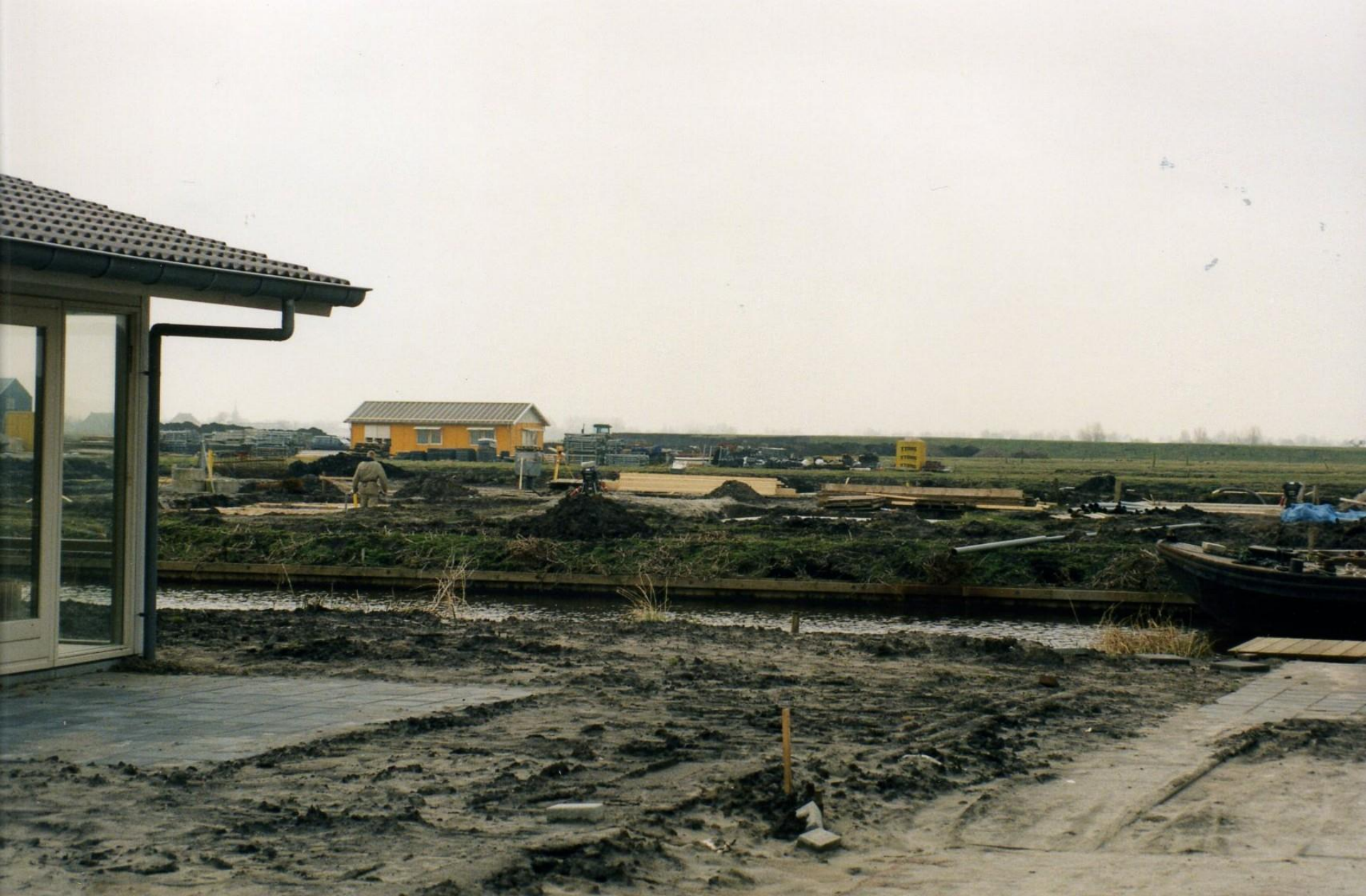
Bouw 2e fase gestart, februari 1999
